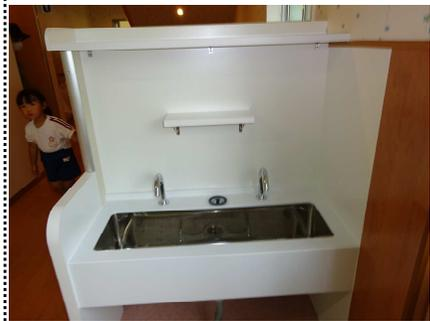
1階東・西トイレに、新たに「手洗い場」を設置しました。これまで、トイレに手洗い場が無く、廊下の手洗い場と共用していました。今回の工事で、トイレの使用後に直ぐに手洗いができるようになりました。また衛生面から、非接触の「自動水栓」にしました。
